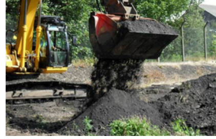
L'EPFL Auvergne assure des travaux de dépollution respectueux de l'environnement
