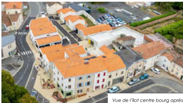
Vue de l'îlot centre bourg après les travaux de réhabilitation
